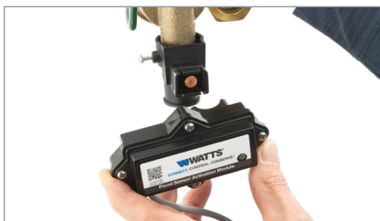
5. Enfoncez le module d'activation sur le capteur.
