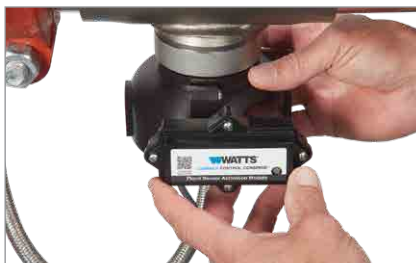
6. Vérifiez que le module est bien en place pour sceller le joint torique et pour établir un contact électrique.
